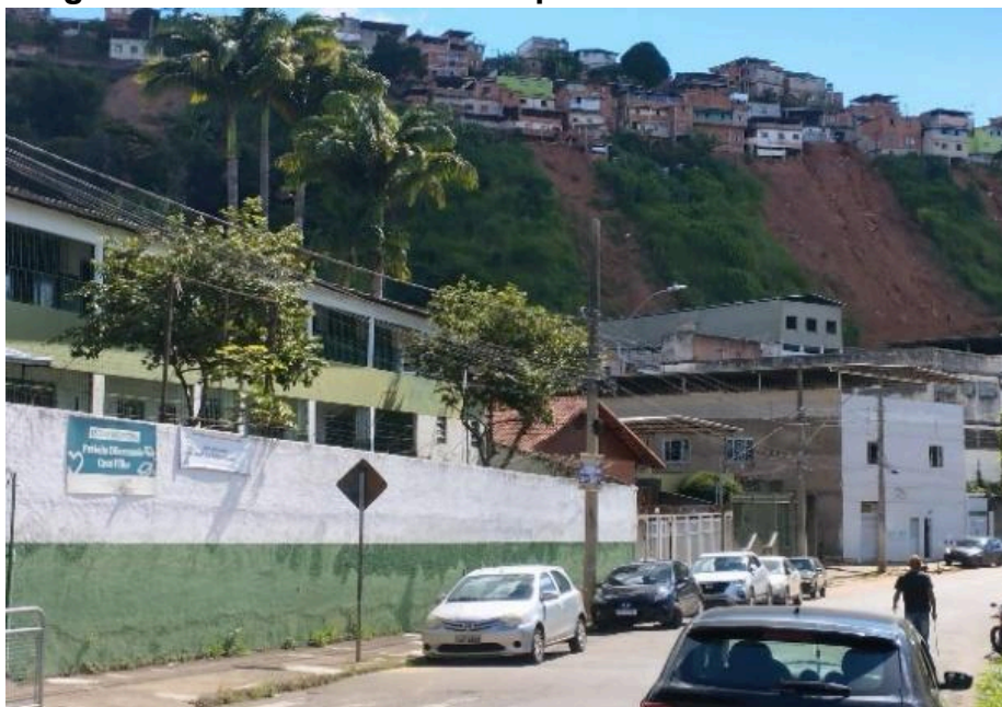
Fotografia 1- Escola e encostas que desabaram em ruas acima
