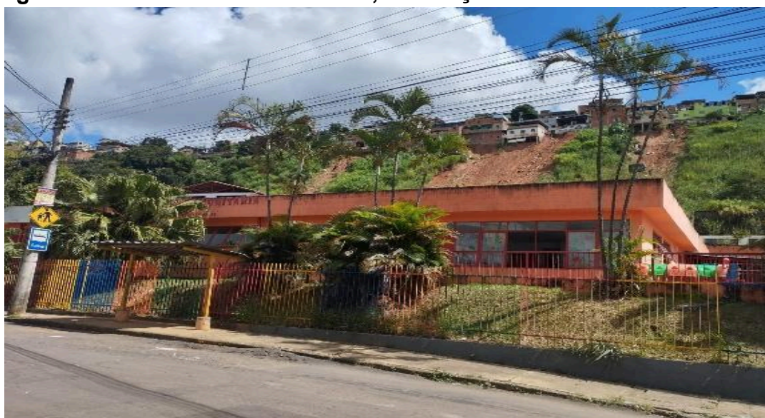
Fotografia 2- creche na rua Miracema, na direção da encosta do desabamento
