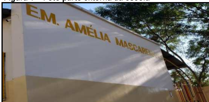
Figura 1 – Foto parte externa da escola
